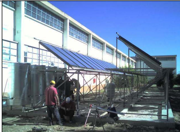
Platform ve beton temeli (yukarıda) Tesisat Montajı (aşağıda)
